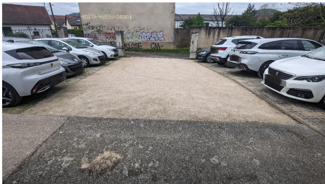
Figure 7 : Parking perméable permettant une meilleure infiltration de l'eau de pluie.
