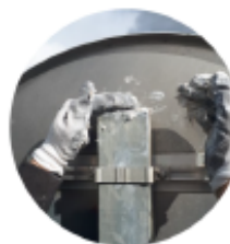
Tasser la pâte et nettoyer le poteau creux et ses alentours.
