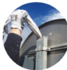
Enfoncer le chiffon dans le poteau pour éviter que la pâte ne glisse.
