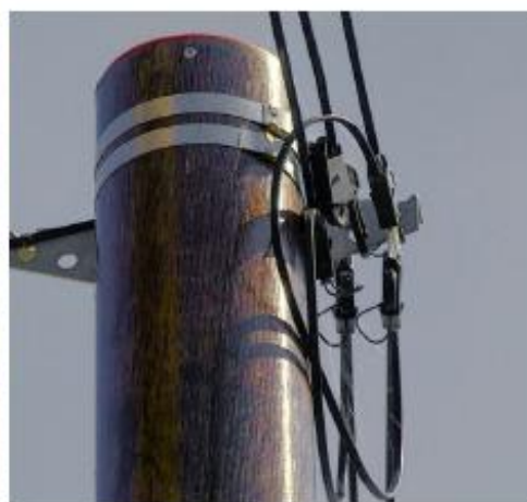
Poteau composite imitation bois, obturé à la fabrication
