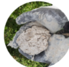
Placer une boule de pâte dans le trou.
