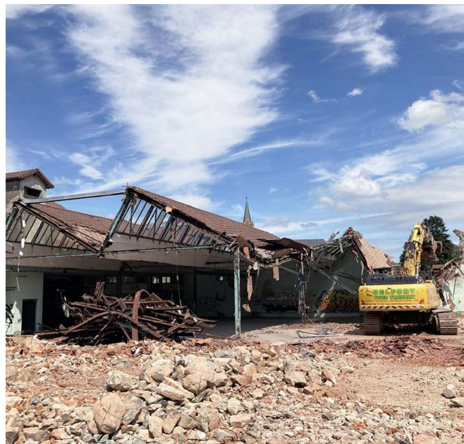
Rougemont le Château, travaux de démolition de bâtiments de la TEEN, Source : EPF Doubs BFC
