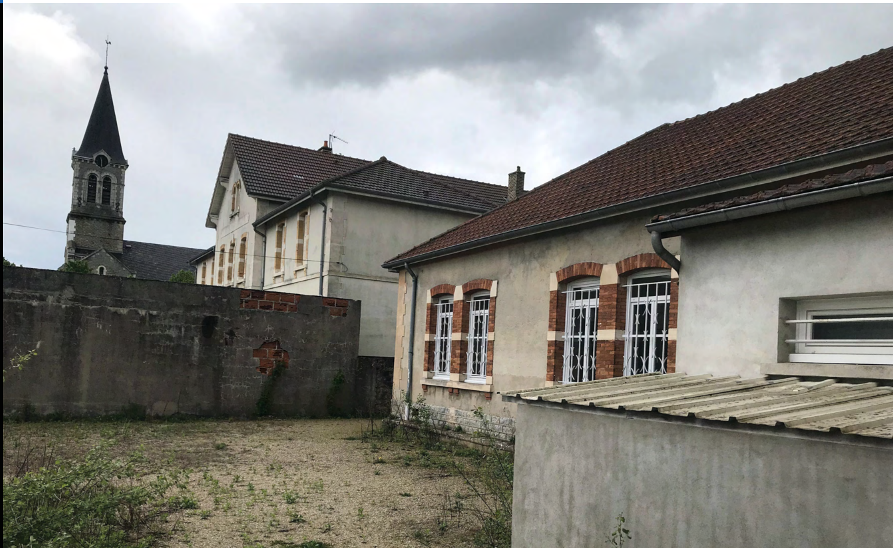
Montceau les Mines, ancien centre paroissial, Source : EPF Doubs BFC
