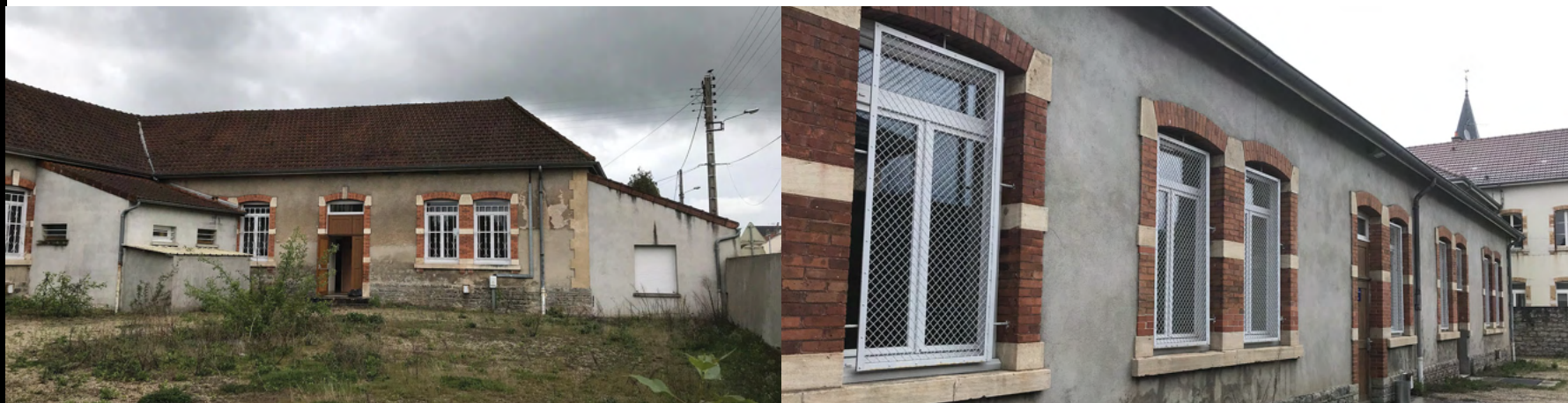
Montceau les Mines, ancien centre paroissial, Source : EPF Doubs BFC
