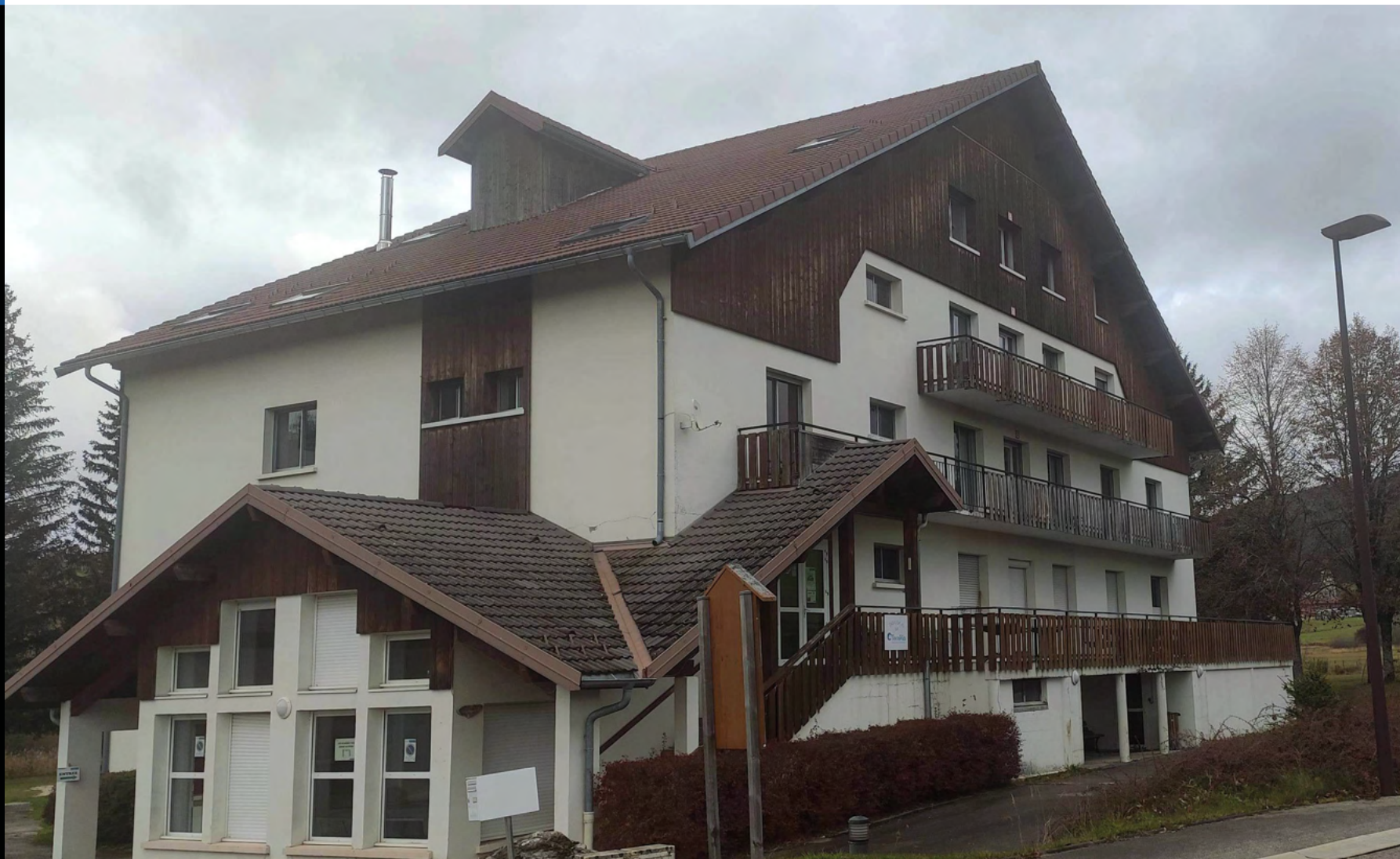
Longevilles Mont d'Or, Centre de vacances «La Roche du Trésor», Source : EPF Doubs BFC
