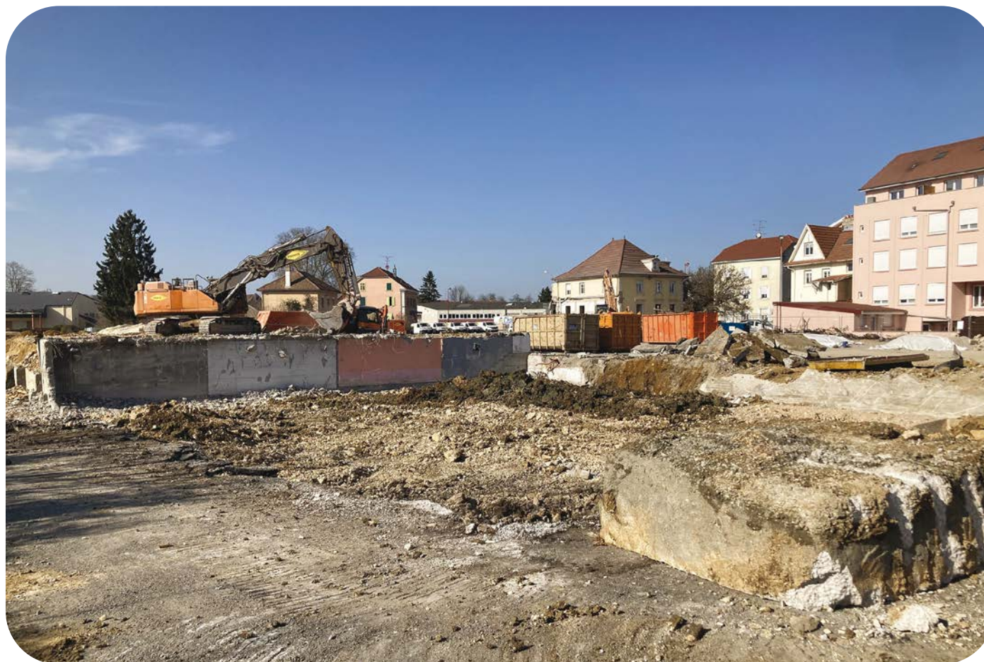
Delle, démolition bâtiments Charpiot, Source : EPF Doubs BFC
