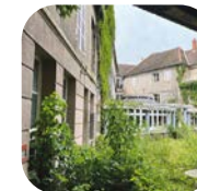
Sécurisation d'un ancien hôtel Autun (71)
