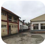
Reconversion d'une ancienne friche industrielle Ornans (25)
