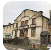
Déconstruction d'un ancien cinéma Montchanin (71)
