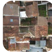
Déconstruction d'habitats dégradés Auxonne (21)
