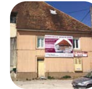
Déconstruction d'un ancien restaurant Frasne (25)
