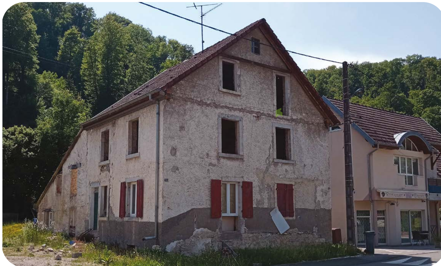
Meslières, bien en état d'abandon, Source : EPF Doubs BFC
