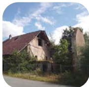
Déconstruction de deux fermes dégradées Grandvillars (90)
