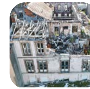
Déconstruction et désamiantage d'un bâtiment fortement dégradé Luxeuil Les Bains (70)
