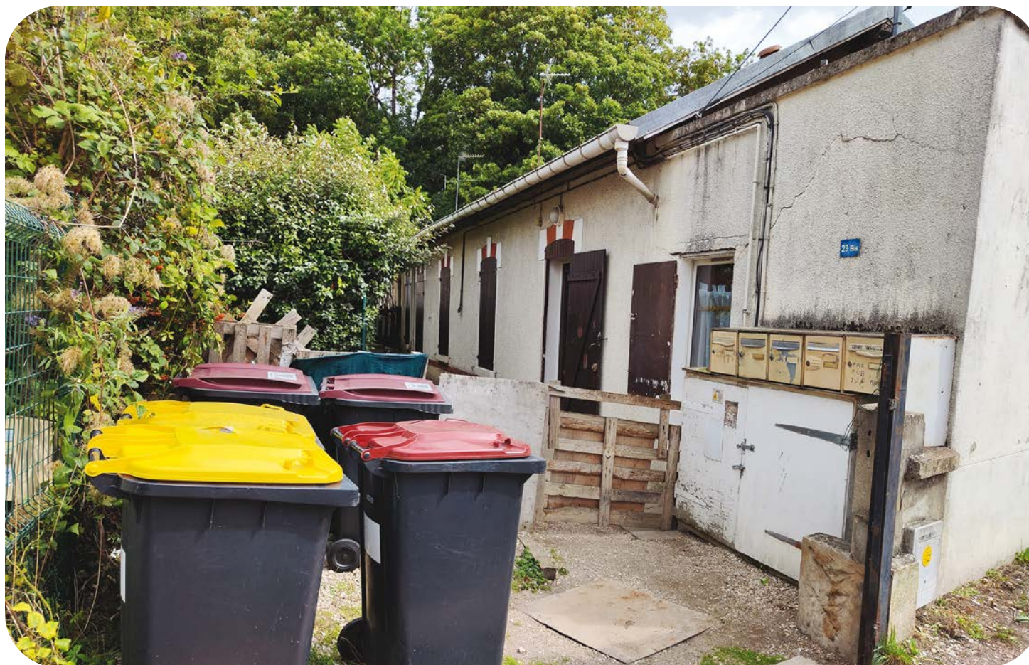
Auxerre, acquisition par préemption, Source : EPF Doubs BFC
